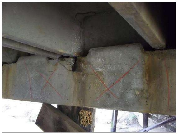
BENT 2 CAP NORTH FACE AT BEAM 7, DELAMINATION (4FT X 16IN)
