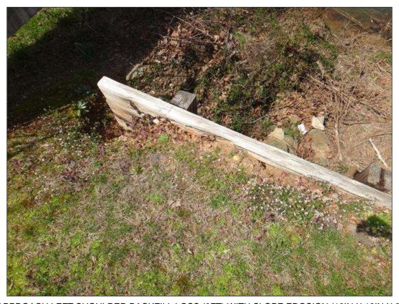
SOUTH APPROACH LEFT SHOULDER BACKFILL LOSS (6FT) WITH SLOPE EROSION (18IN X 18IN X 24IN DEEP)
