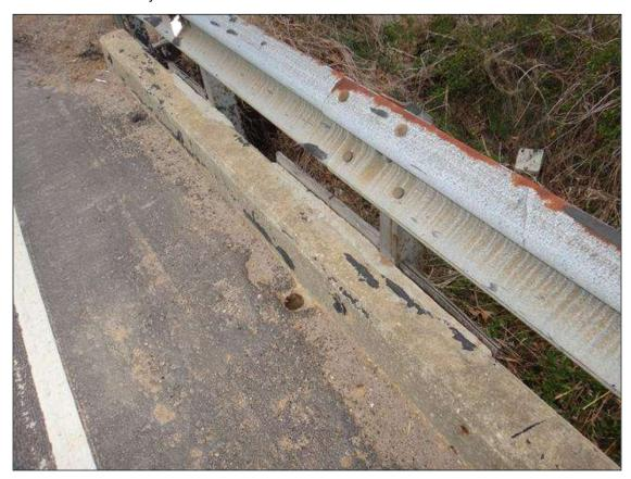
SPAN 3 RIGHT PARAPET, PREVIOUS REPAIRED SPALLS AT RAIL POST 4,5
