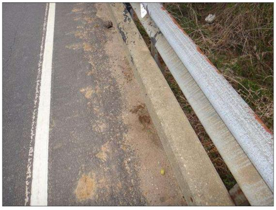
SPAN 3 RIGHT SHOULDER, ONE (1) CLOGGED SCUPPER DRAIN
