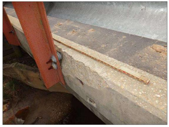
SPAN 1 RIGHT PARAPET, SPALL (30IN X 8IN X 3IN DEEP) WITH EXPOSED RUSTED REBAR AT RAIL POST 5
