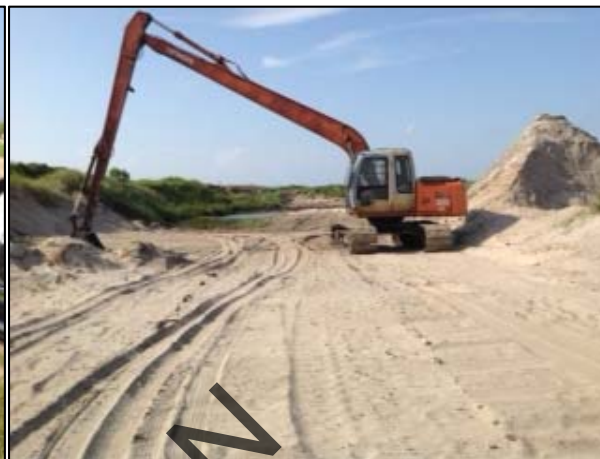
Photo 2. Customized Mini Excavator
