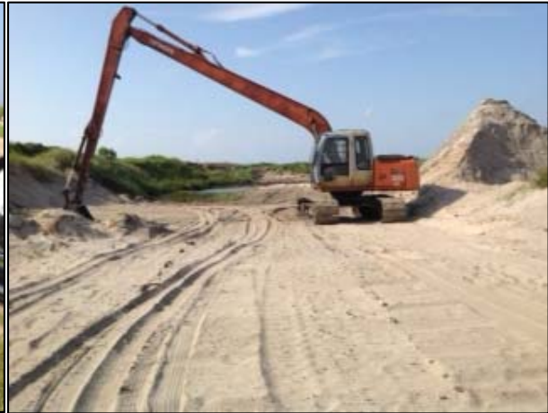
Photo 2. Customized Mini Excavator
