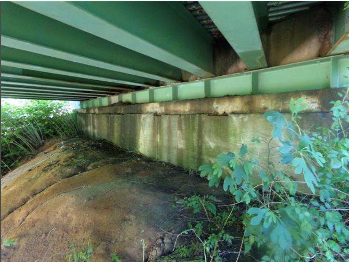
End Bent 2 (End Bent 1 similar)
