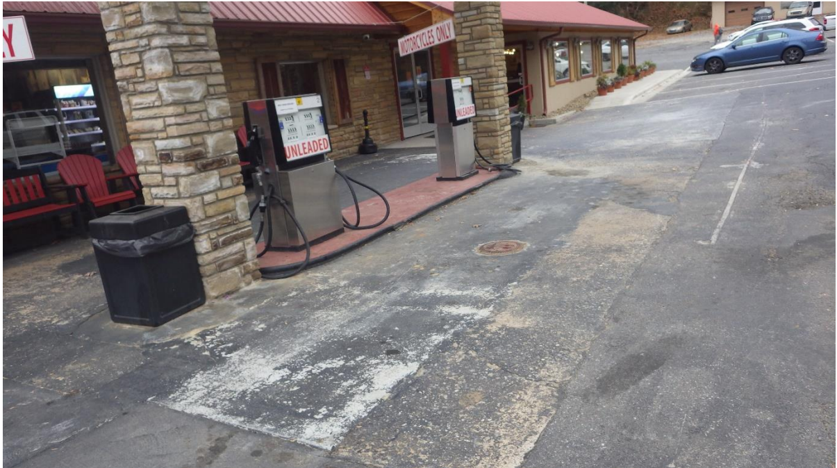
UST fill port
