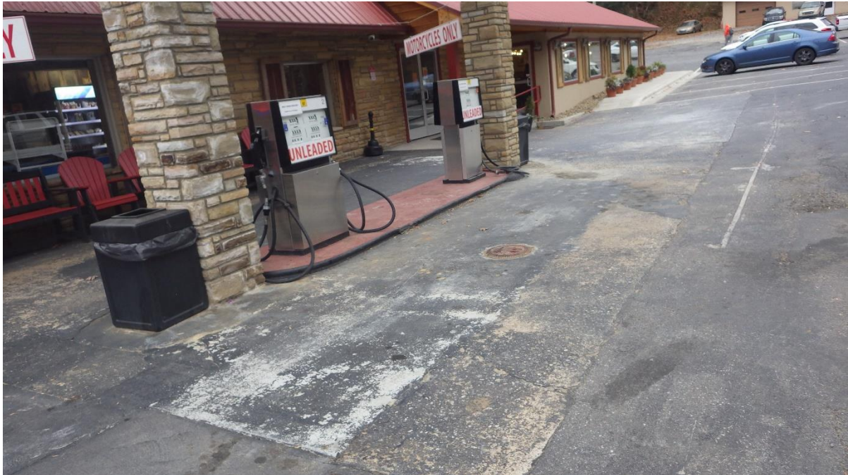
UST fill port
