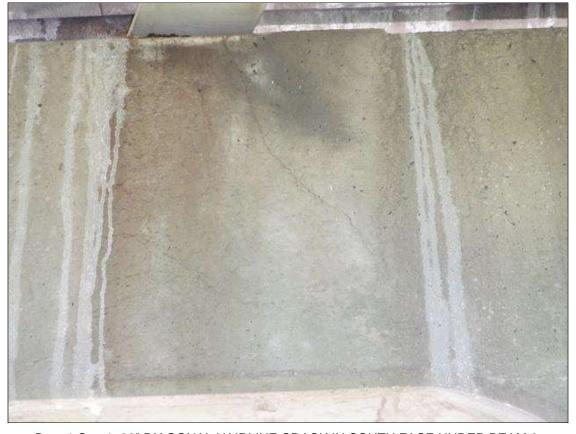
Bent 1 Cap 1: 36" DIAGONAL HAIRLINE CRACK IN SOUTH FACE UNDER BEAM 3
