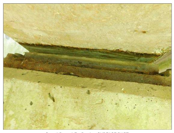
Span 2 Beam 2 Far Bearing: SURFACE RUST
