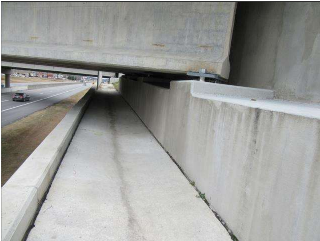
END BENT 2 CLOSE UP
