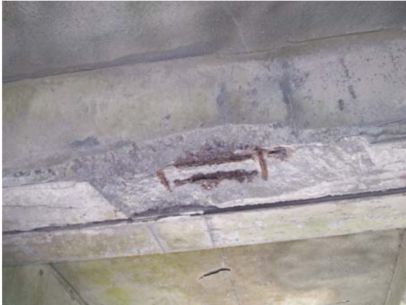
Span 149-150; SP & ER on soffit EJ Beam,
