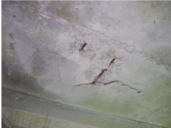
Span 162-163; SP & ER on soffit, East bay,
