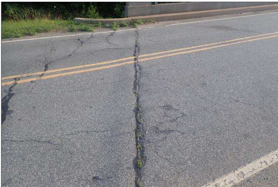
end bent 2 asphalt
