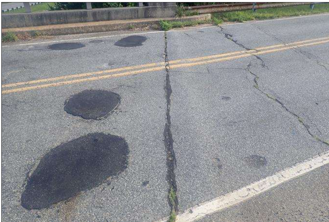
end bent 1 asphalt
