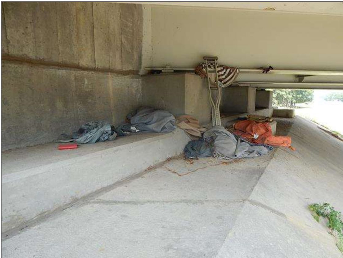
End Bent 1 (End Bent 2 similar)
