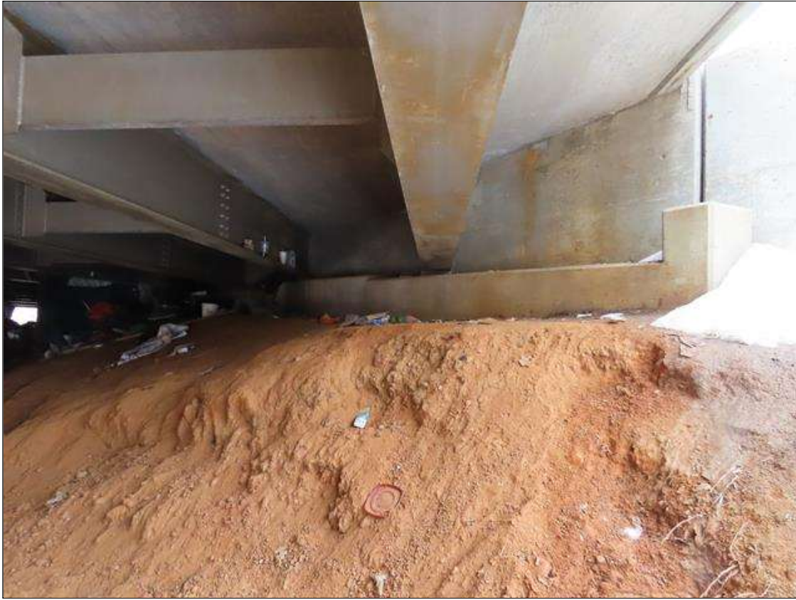
END BENT 1, LEFT SIDE
