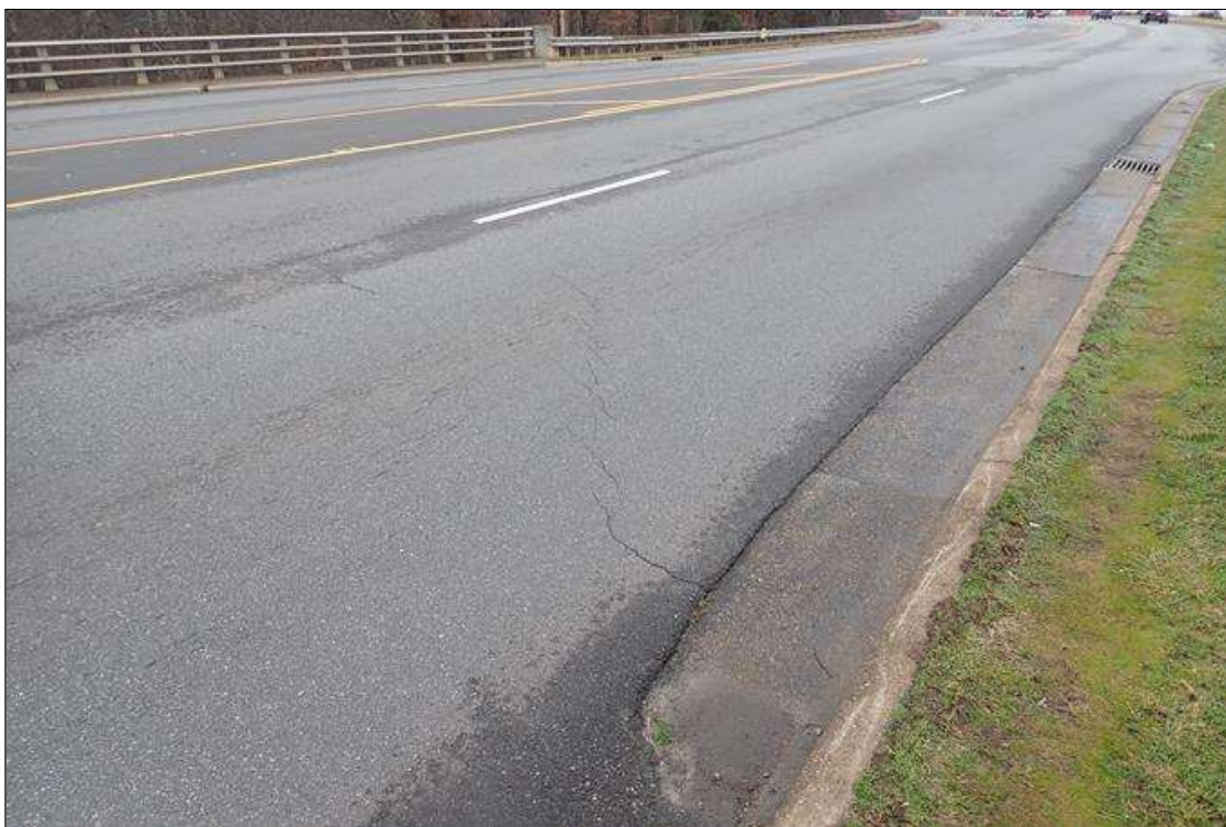
end bent 2 asphalt
