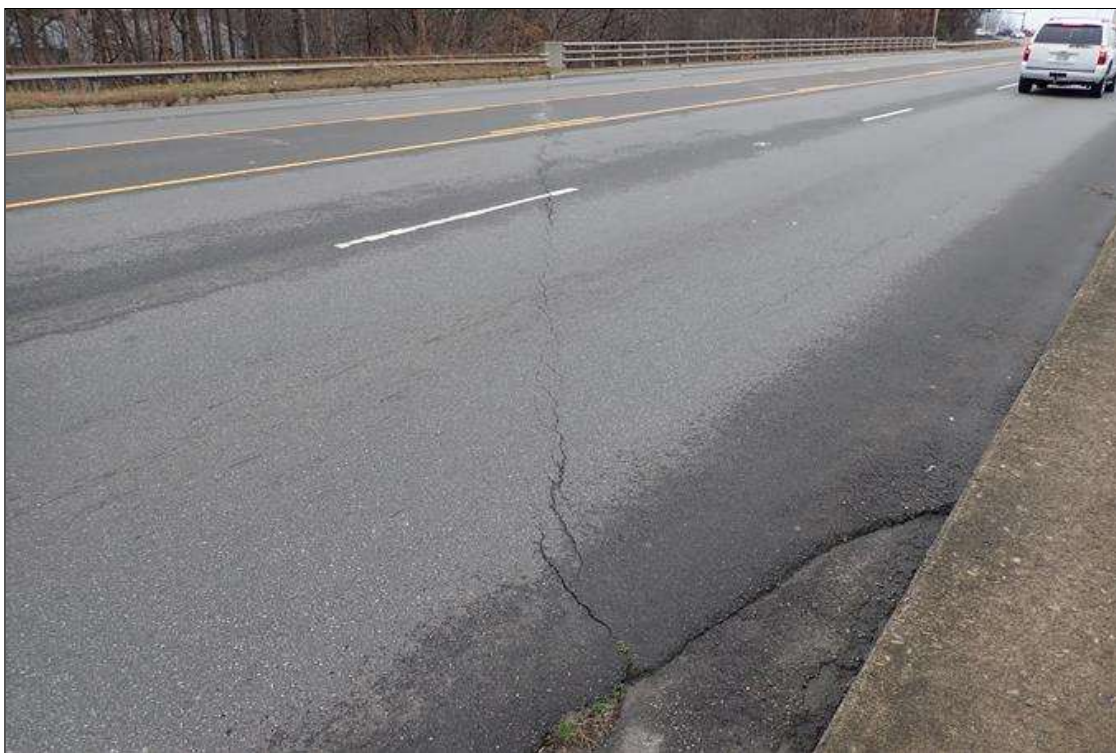
end bent 1 asphalt
