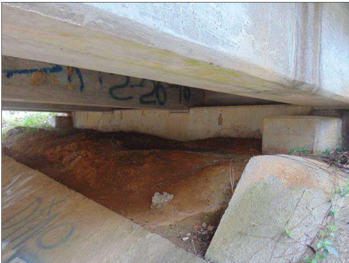
End Bent 1 (End Bent 2 similar)
