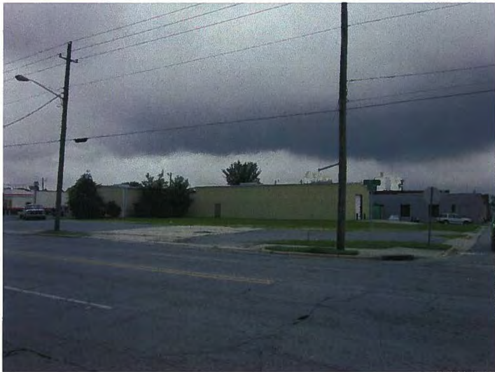
Parcel 101 (Walter L. Williams Property), looking north
