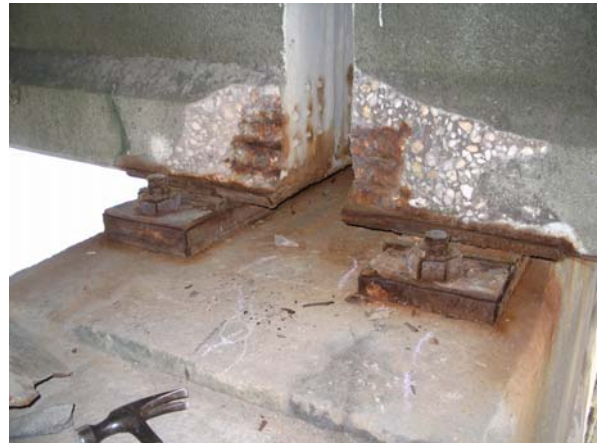
Bent 164, top of bent cap
